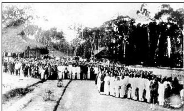
LỄ KHỞI CÔNG XÂY CÁT TÒA THÁNH
